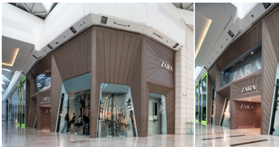
Gli 81 pannelli di HI-MACS® e le 3 lamine di acciaio ricoprono una superficie totale di 146,50 metri quadrati.
